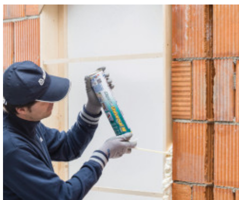
Ausfüllen von Hohlräumen zwischen Fensterrahmen und Wand
