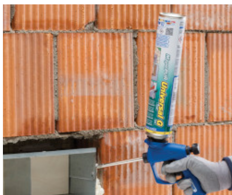
Ausfüllen eines Lüftungskanales
